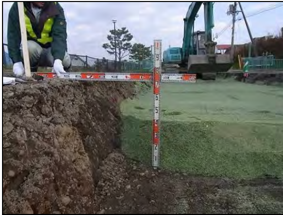
写真-2 ガラスカレット工区の施工状況
