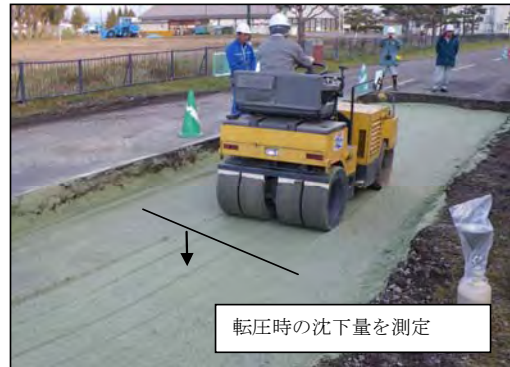
写真-5 ガラスカレット工区の施工状況
