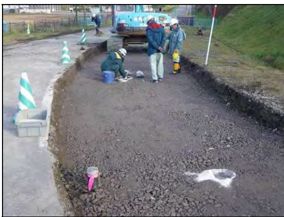
写真-3 比較工区の施工状況
