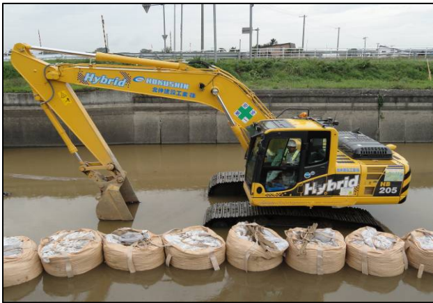
写真-6 ハイブリッド油圧ショベル使用状況 「北海幹線水路 宮尾橋上流工区工事」
