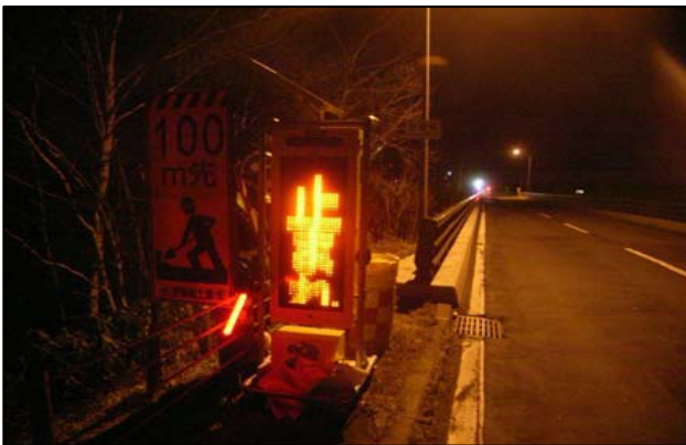
写真-7 ソーラー式電光掲示板使用状況 「一般国道230号 札幌市 豊平峡法面補修外一連工事」
