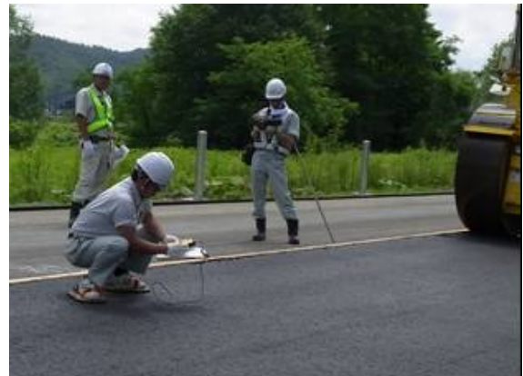
写真-2 サーモグラフィーによる敷均し温度の計測状況
