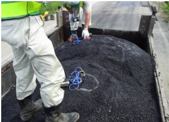
写真-1 現場到着時の混合物温度の計測状況
