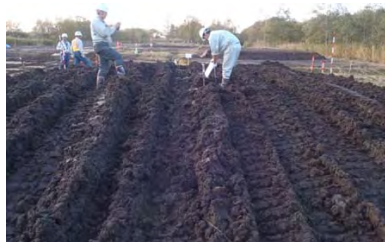
写真-14 転圧状況(夕H22No. 8転圧困難)
