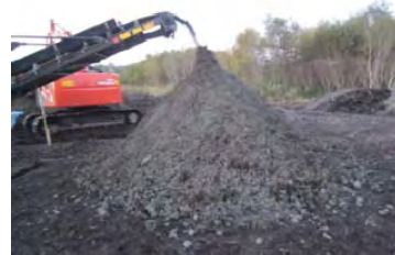
写真-9 自走式(A)攪拌状況(H22施工)
