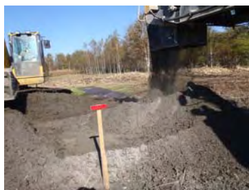
写真-11 自走式(B)攪拌状況(H23施工)
