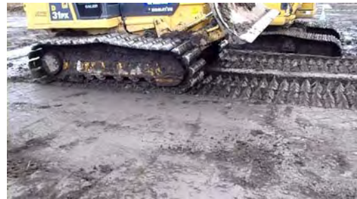
写真-15 代表的な転圧状況写真(夕H22No. 10)
