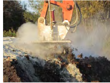
写真-7 ローター式スプレイダ攪拌状況(H22施工)
