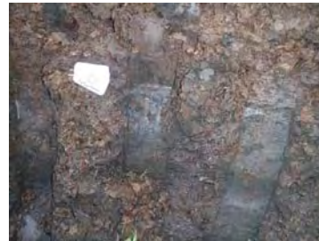
写真-8 破碎時状況(H23施工、灰色がセメント部)
