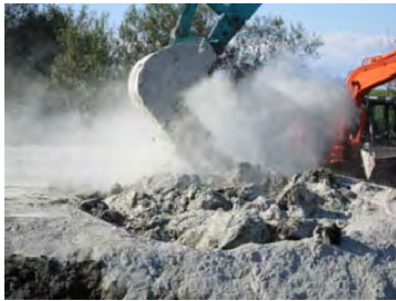
写真-5 バックホウ攪拌状況(H22施工)
