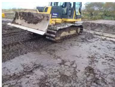
写真-13 代表的な転圧状況写真(夕H22No. 4)
