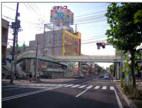
写真-1 横断歩道橋全景
