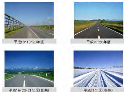
写真-1 道路の内部景観写真
