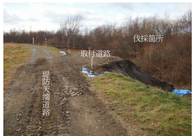
写真-3 取付道路設置状況
