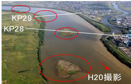
写真2 土砂堆積による砂州の状況 (石狩川)
