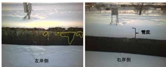
写真-2 平成23年2月3日17時の左右岸側壁の状況 (黄色破線内は側壁表面が濡れている箇所)
