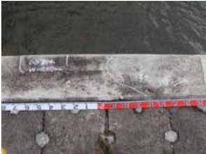
写真-11 右岸擁壁天端
