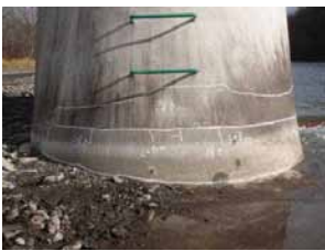
写真-13 P2堰柱
