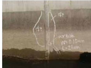
写真-12 右岸擁壁側壁
