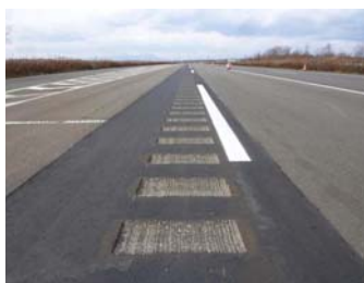
写真-1 大型車両へ対応した規格のランブルストリップス
