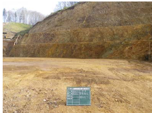
【写真3 基盤排水層床面状況】
