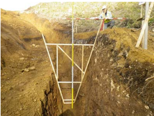
【写真7、遮断排水床掘り状況】
