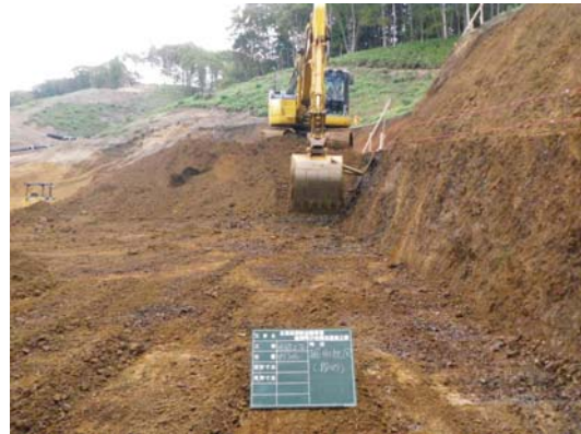
【写真1 段切り施工状況】
