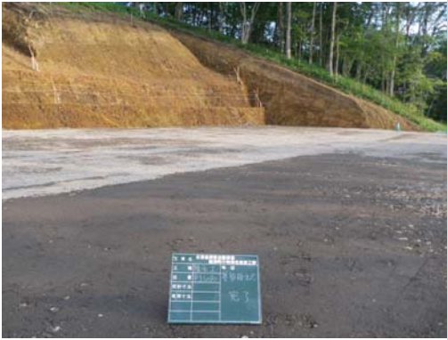
【写真4 基盤排水層完了】
