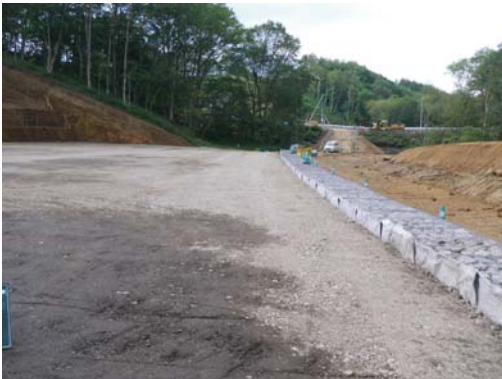
【写真5、基盤排水層吐口フトン管設置】
