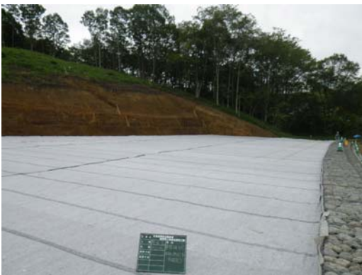
【写真6、基盤排水層吸出し防止材設置】
