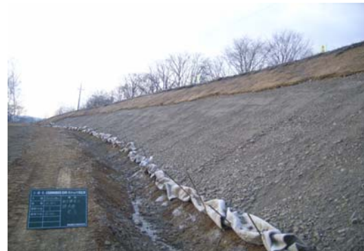
【写真9、切り土法面排水層敷設】
