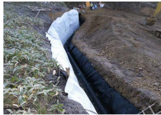
【写真8、吸い出し防止材・遮水シート設置】
