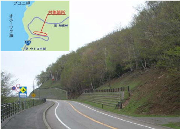
写真3 落石防護柵設置予定箇所
