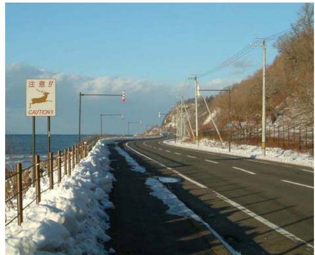
写真-1 国道334号の海岸線
