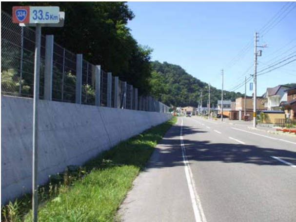
写真-5 ウトロ市街の落石防護擁壁設置区間
