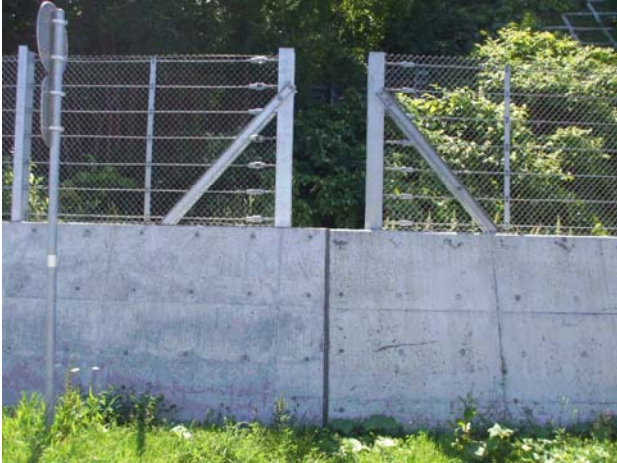
写真-7 階段設置予定地
