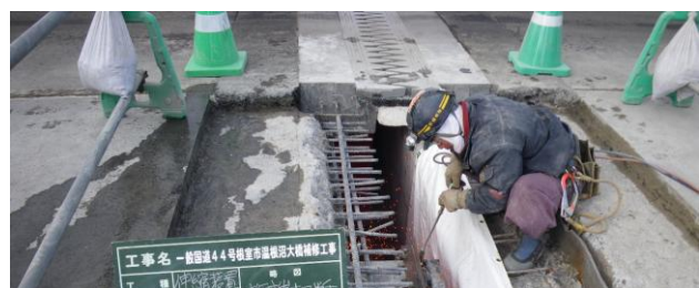
写真-5 桁端部切断および伸縮装置取替
