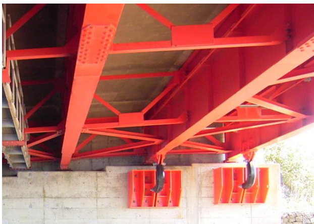
写真-2 A-2 落橋防止構造
