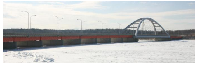
写真-1 温根沼大橋全景
