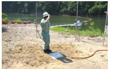
写真-6. 振動検知センサー動作確認状況
