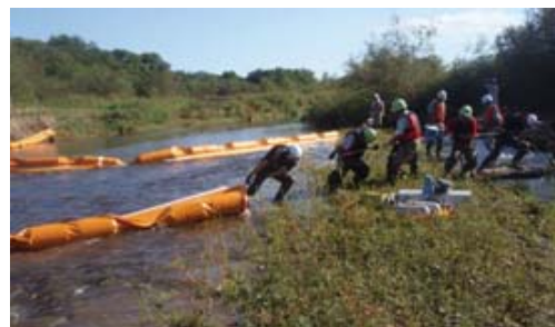
写真-2 オイルフェンス引き寄せ状況
