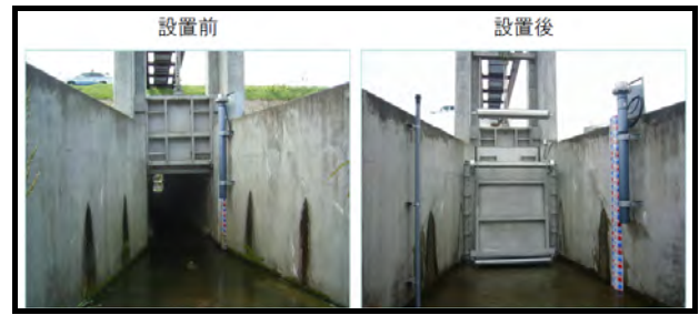
写真-7 樋門操作遅れ防止のフラップゲート設置前後
