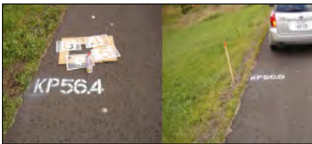
写真-6 ステンシルによる距離標の路面表示
