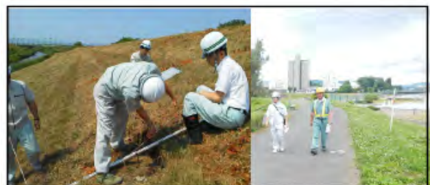
写真-1 職員による堤防点検の様子
