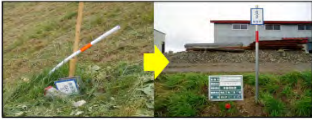
写真-2 単管距離標見出し杭の設置
