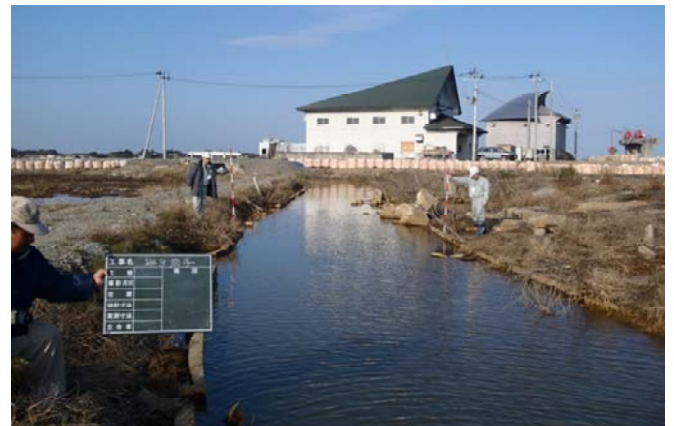
写真4 被災箇所の測量
