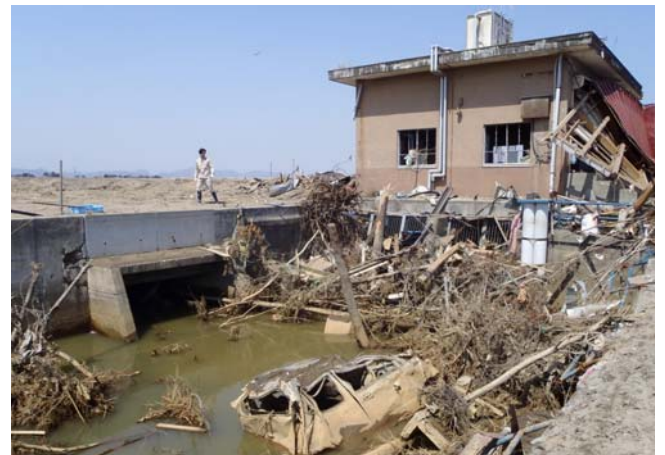
写真-2 被災した揚水機場
