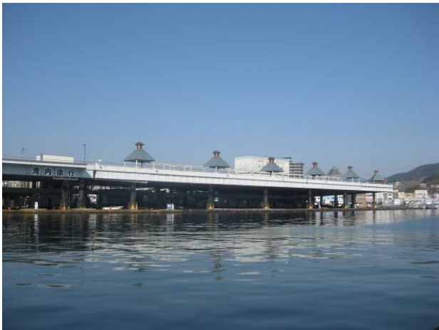
図-13 漁港内の人工地盤による津波避難（気仙沼漁港）
