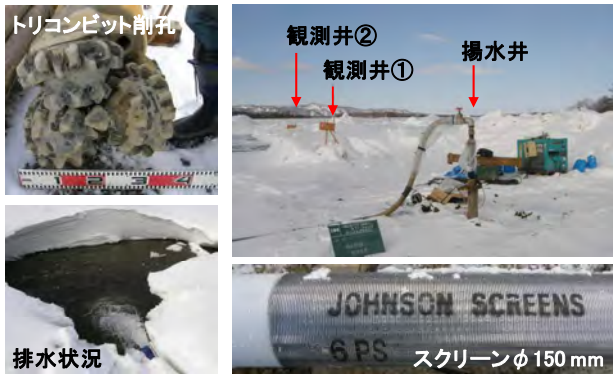
図-7 揚水試験状況
