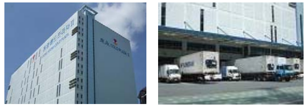
(a) 冷凍冷蔵倉庫 (b) 冷凍品の積み出し状況
