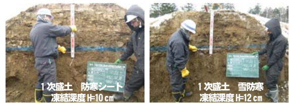
写真-4 試験盛土開削凍結深度確認 (H24/3/6時点) (左:防寒シート, 右:雪防寒)
