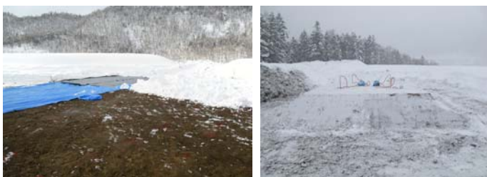
写真-3 試験盛土完成状況
