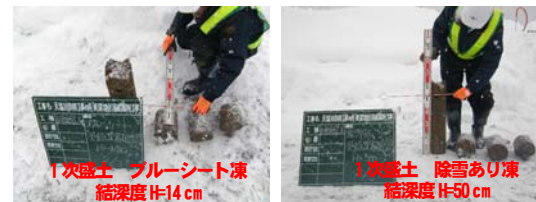
写真-7 試験盛土コア凍結深度確認 (H24/2/3時点) (左:ブルーシート, 右:裸地)
