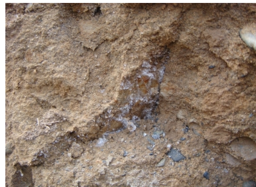
写真-8 開削時に確認された盛土内のレンズ状の水
