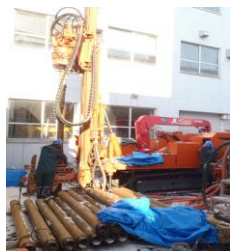
写真-4 採熱孔掘削
