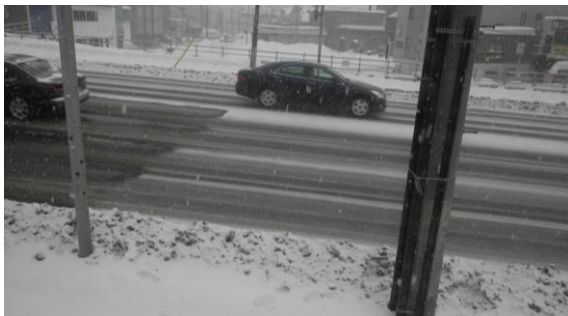
写真-1 ロードヒーティングの稼働状況
