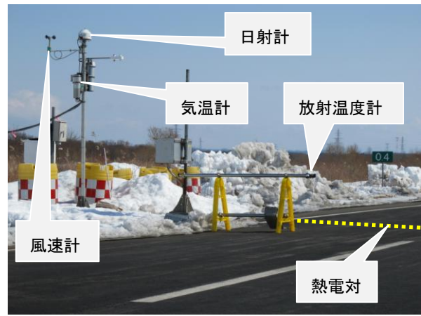
写真-1 観測機器設置状況
