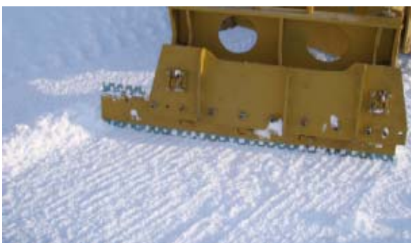
写真-7 排雪装置併用施工後の路面
