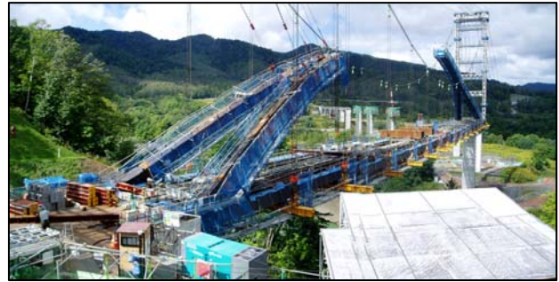
図-13 現場施工状況 (H24. 9. 26)
