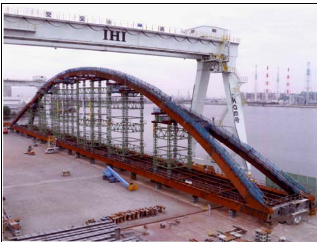
図-12 C橋工場仮組検査時 (H24. 5. 21)
