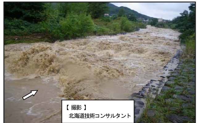
図-5 真駒内川分散型落差工(H23年9月出水) (出水時の荒れた流況)
