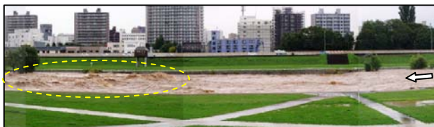
図-2 豊平川5号床止(H23年9月出水) ：三角波
