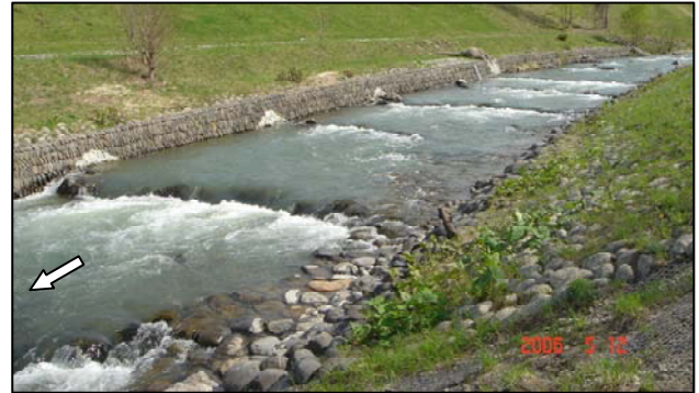
図-4 真駒内川分散型落差工(平常時)
