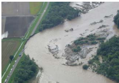
写真-1 堤防の一部流出箇所の状況（H23.9.7撮影）
