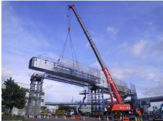
写真-2 トラッククレーンベント工法
