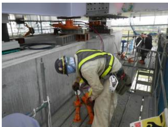
写真-6 推進ジャッキ型送り台による桁修正
