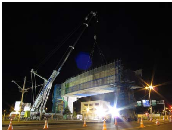
写真-3 函館新道 大ブロック架設工法
