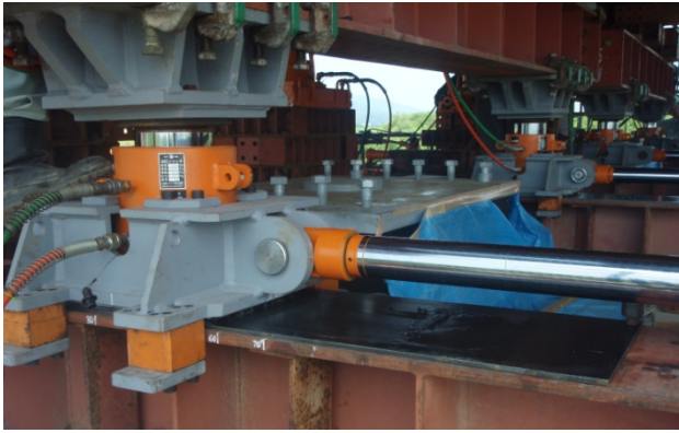
写真5 縦送り装置（油圧ジャッキ）
