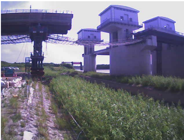
写真6 河川区間縦送り前
