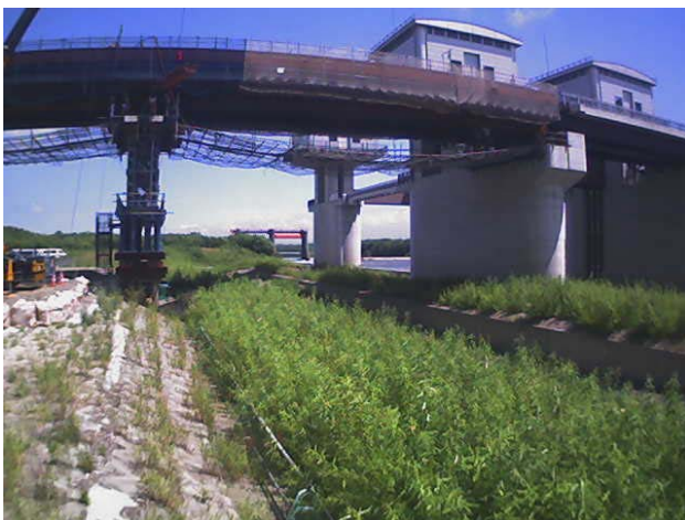
写真7 河川区間縦送り後
