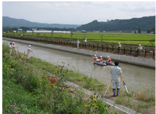
写真-1 水路底のレベル測量概況(通水時)
