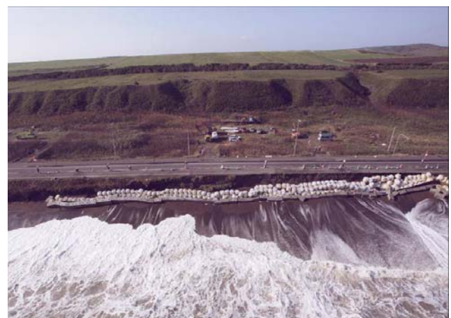
図-2 海岸侵食状況
