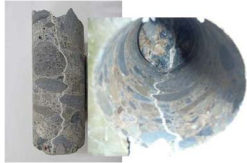
写真-3 削孔コアと削孔内の状況例
