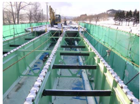
写真-7 床版の撤去
