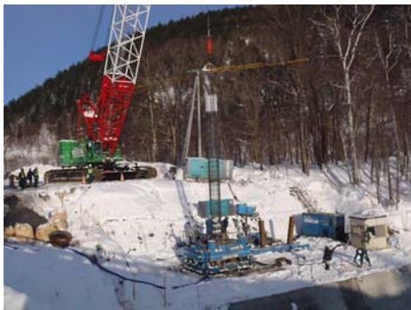
写真-10 場所打ち杭の打込み
