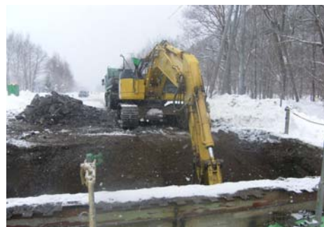
写真-6 A-1背面盛土の撤去
