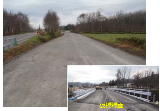
写真-4 仮道の設置
