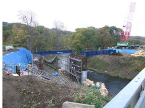
写真-5 一般交通用仮橋の設置
