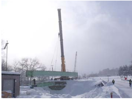
写真-8 主桁の撤去
