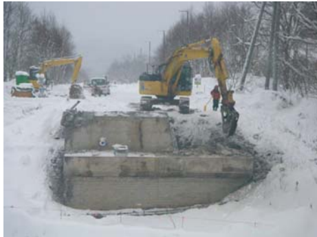
写真-9 橋台の解体
