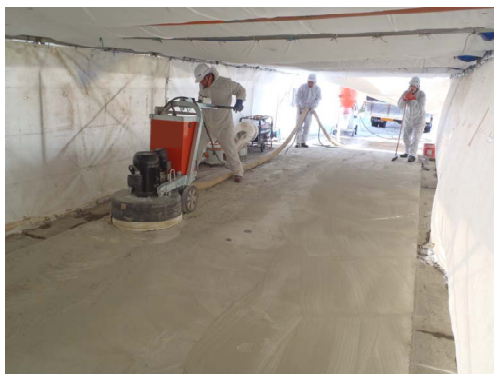
(a) コンクリート表面の研掃の状況
