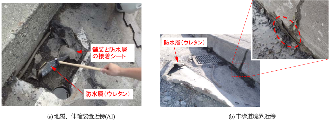
図-4 防水層の状況
