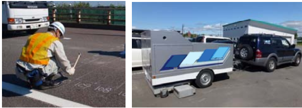
(a) 叩き点検 (b) 電磁波を用いた調査
