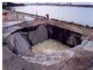
図-1 左：鋼矢板岸壁の損傷による裏込め土の吸い出し、右：岸壁内部の空洞化により陥没した路面
