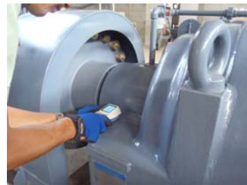
写真-1 振動調査作業
