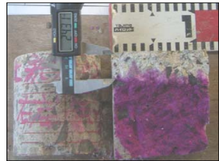
3号水路橋上流側右岸壁気中部
