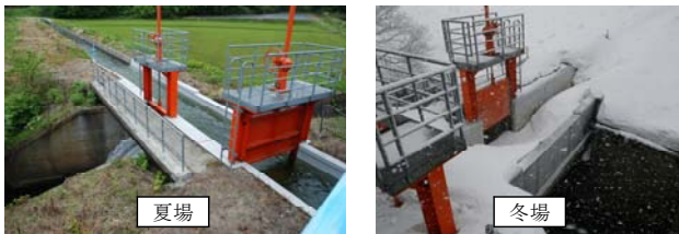
写真-1 1号水路橋補修後の夏場・冬場状況
