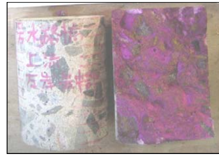
1号水路橋上流側左岸壁気中部
