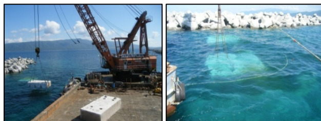
写真-2 嵩上げ施工状況
