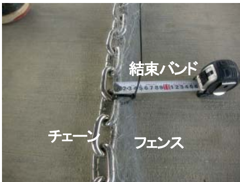
写真-4 ウニ侵入防止フェンスの構造
