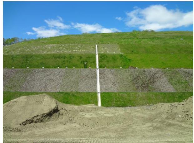
写真-1 試験施工箇所の状況 (試験地1)
