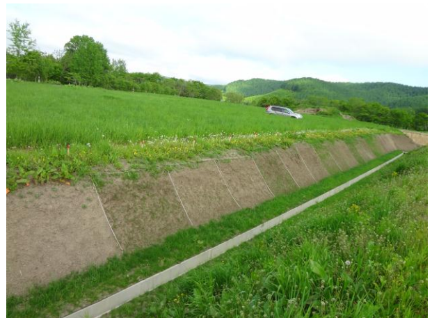
写真-2 試験施工箇所の状況 (試験地2)
