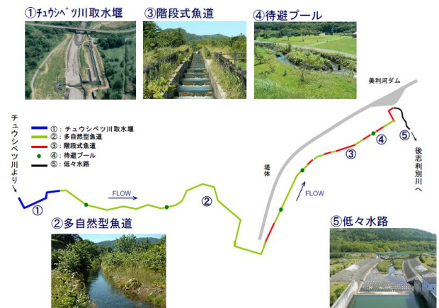
図-4 日本一の魚道延長を誇る美利河ダムの取り組み
