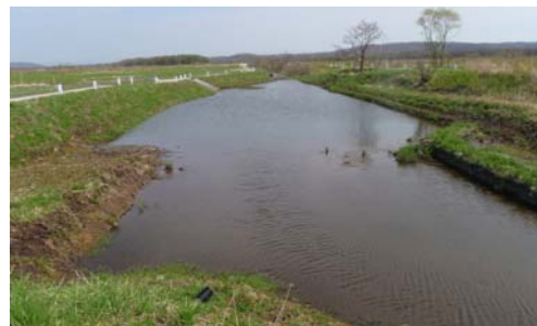
写真1 排水路下流部の沈砂池
