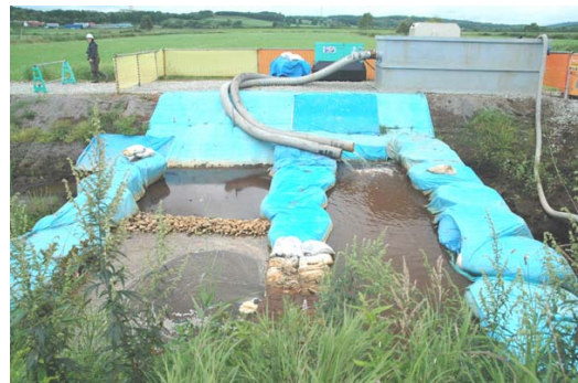
写真3 排水路工事における汚濁処理施設
